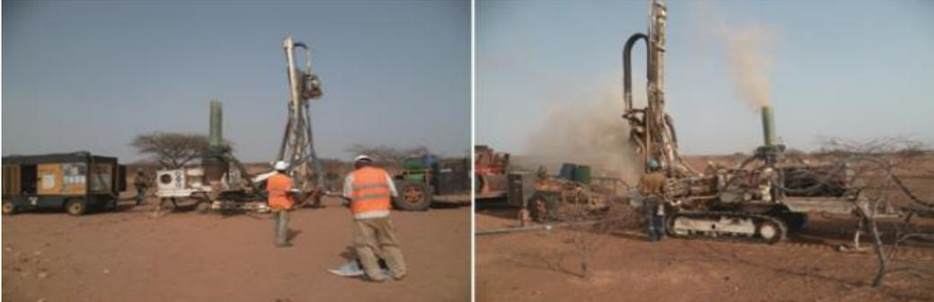
**Figure 2 :** Foration rotative à l'air comprimé
