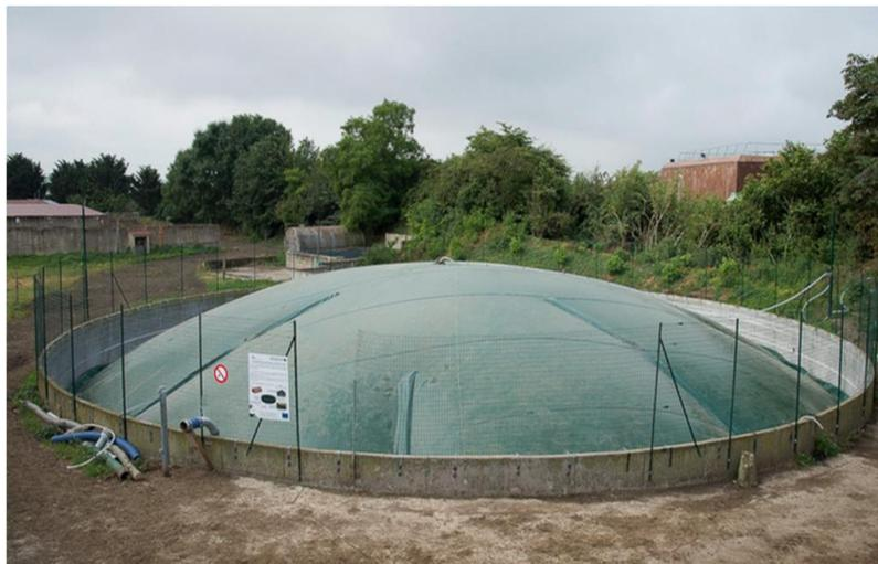
**Figure 8 : digesteur type fosse infiniment mélangé [42]**
