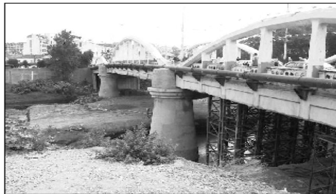
Fig II.6 Vue générale du Pont Blanc d'EL Harrach [27].
