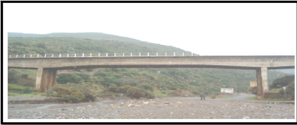
Fig V.12 Vue d'ensemble du pont [33].
