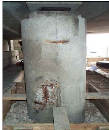
Fig I.1 Pile de pont dégradé [20]. Fig I.2 Poutre de tablier [20]
