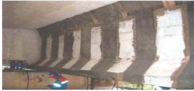
Fig III.2 Réparation des poutres du pont de Gagnac-France par matériaux composites [18].
