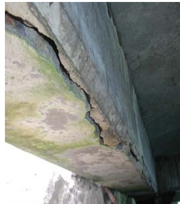
Fig I.1 Pile de pont dégradé [20]. Fig I.2 Poutre de tablier [20]
