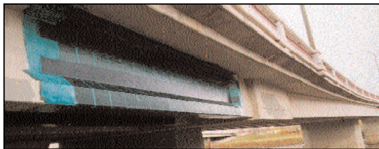
Fig III.3 Renforcement à l'aide de TFC [17].
