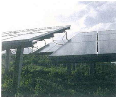
Figure II.43 La distribution défavorable des tables de module est la cause de l'ombrage direct (14)
