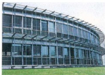
Figure II.42 Ombrage dû aux contrefiches verticales du balcon de secours (14)
