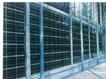
Figure II.42 Ombrage dû aux contrefiches verticales du balcon de secours (14)
