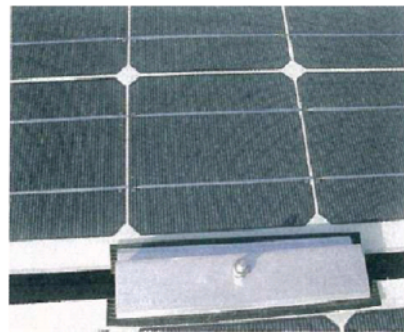
Figure II.44 Micro-ombrage dû à la projection de visses. (14)
