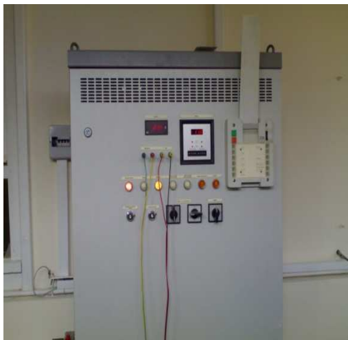
Figure 4.1.a : Photos du convertisseur réversible de charge/ décharge
