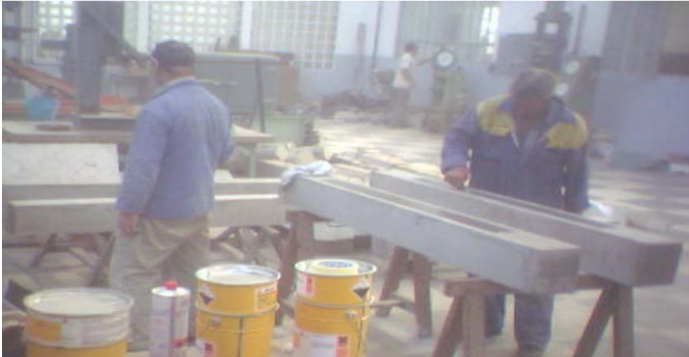
Fig.4.20 Préparation de la surface et pose de la lamelle
