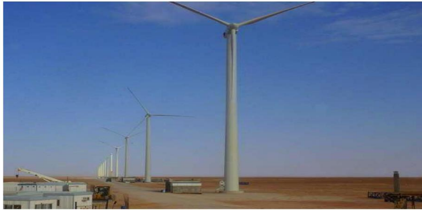
Figure 1-5 : 1 ère ferme éolienne en Algérie.
