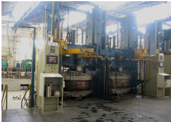
Figure 39 – Poste chargement de 2 presses.
