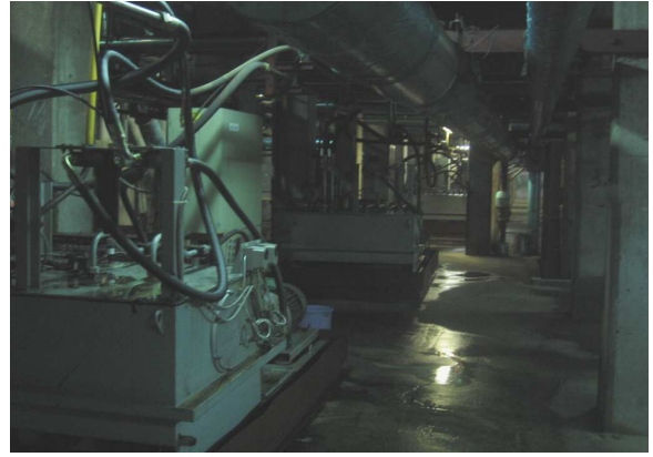
Figure 38 – Le sous sol des cuissons.
