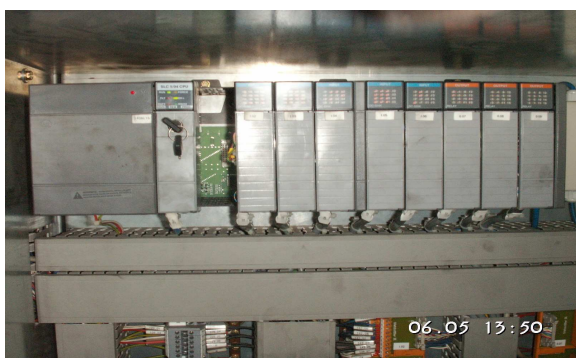
Figure 59 - Automate CPU, modules entrées / sorties.
