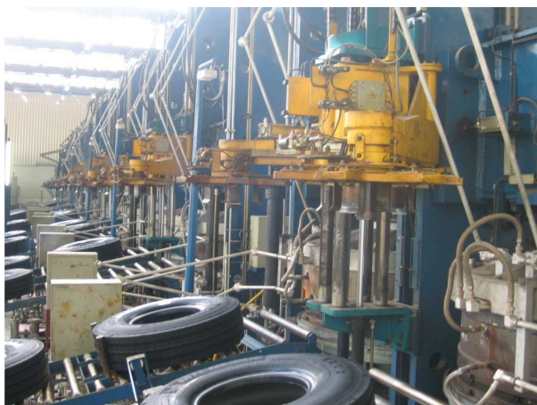
Figure 79 – Potence de déchargement.
