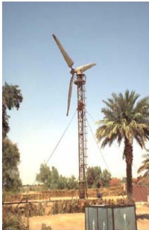
Fig. 1-19 : Aérogénérateur de pompage – INRA –Adrar
