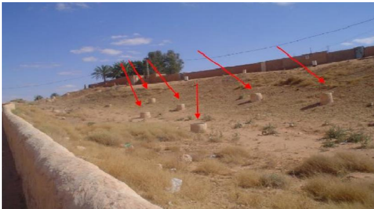
Figure III.11. Puits d'aération. (DJOUDI et RAFA, 2009).
