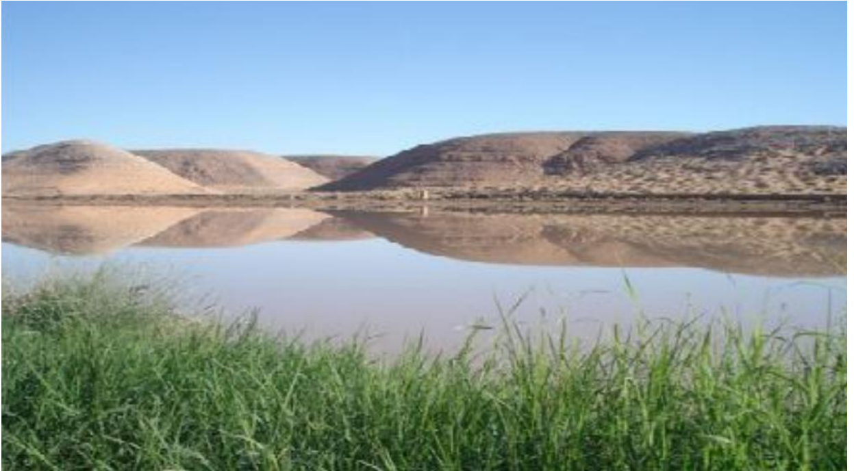
Figure III.8. Retenue de barrage Bouchen (Projet DELTA, 2004).
