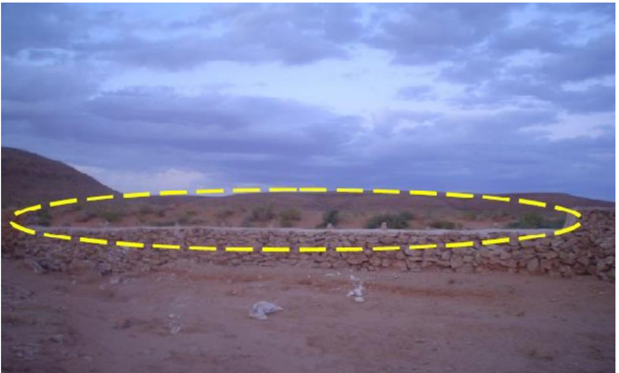
Figure III.5. Déversoir de canal de Bouchemdjén vers le canal de Bouchen (DJOUDI et RAFA, 2009).
