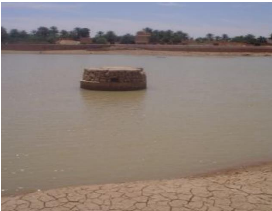
Figure III.9. Puits capteur dans la retenue de barrage Bouchen (DJOUDI et RAFA, 2009).
