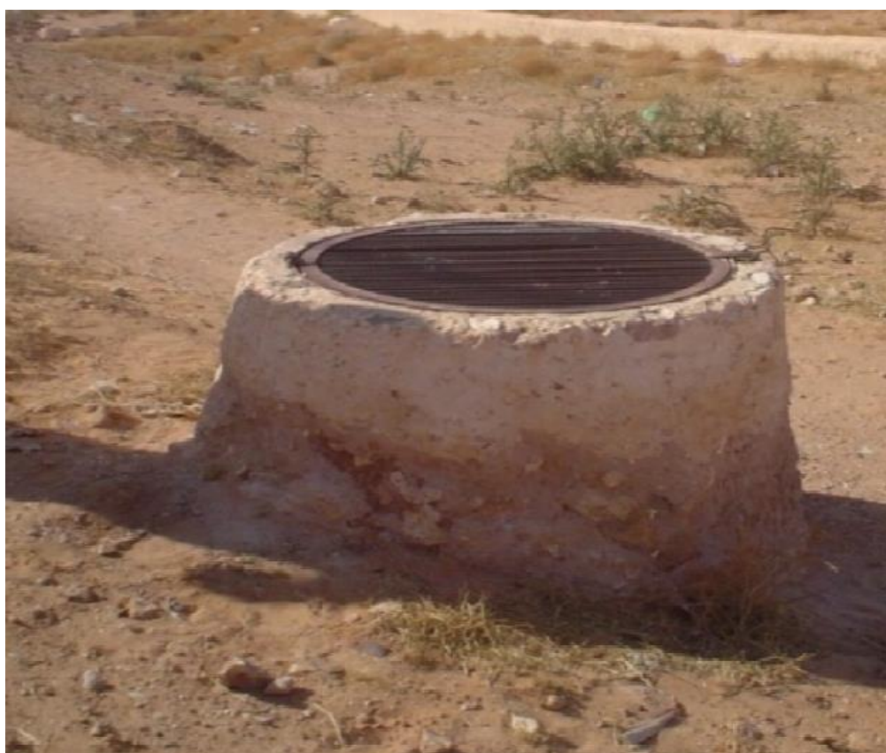
Figure III.12. Puits d'aération (DJOUDI et RAFA, 2009).
