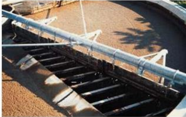
Figure I.6. Épaississement des boues. (Laredj, 2013)
