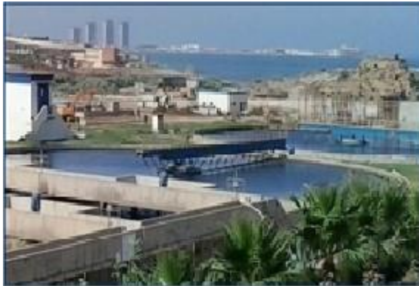
Figure III.5 – Décanteur-Clarificateur (Bennaceur, 2019).
