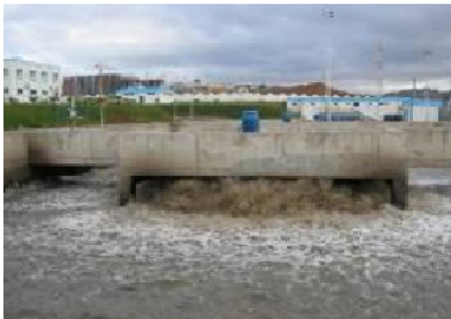
Figure III.4 : Turbine en fonctionnement (Bennaceur, 2019).
