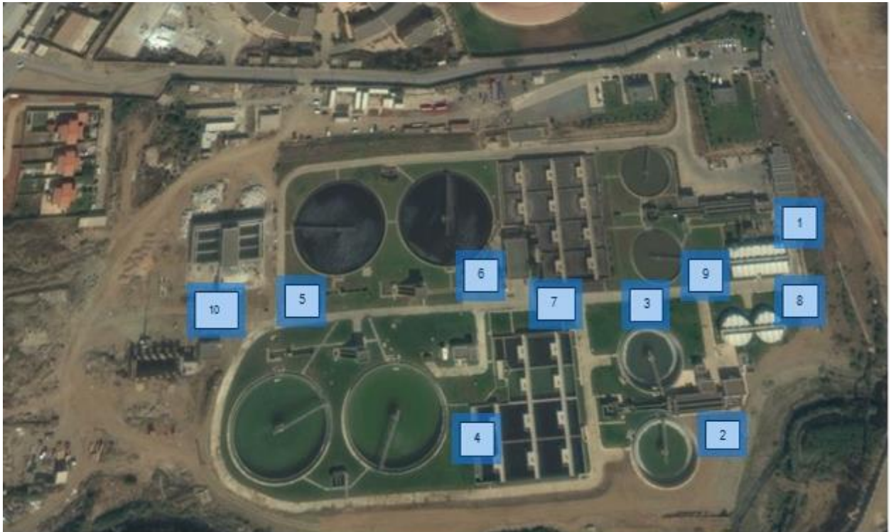
Figure III.2 : Vue d'ensemble des ouvrages de la STEP de Béni Messous par Google Earth. (Bennaceur, 2019)
