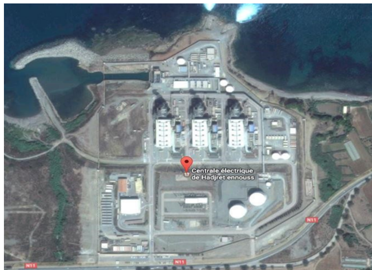
Photo 1.1 – Vue satellite de la centrale à cycle combiné Hadjret Ennous par Google Earth.
