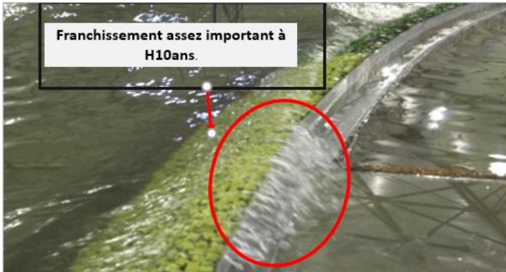
Photo 5.8 : Franchissement assez important à H10ans.
