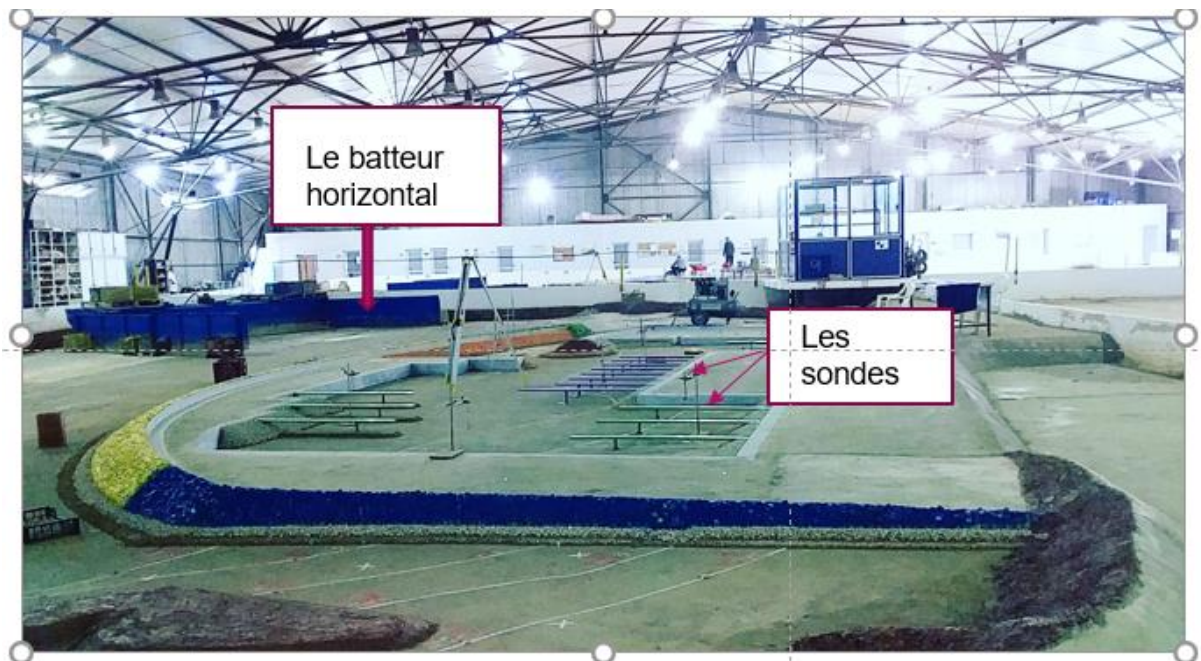
Photo 5.1 : Etat initiale du bassin à houle.
