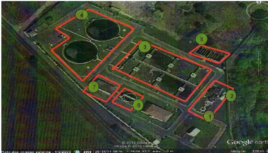
Figure 44.28: Photo de la STEP par Google Earth
