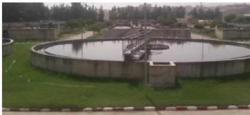
Figure 44.4 : Décanteur-Clarificateur. (DJAOUI.Toufik, 2016).
