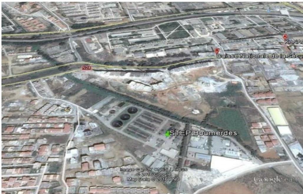
figure 4-1 Vue globale de la station.
