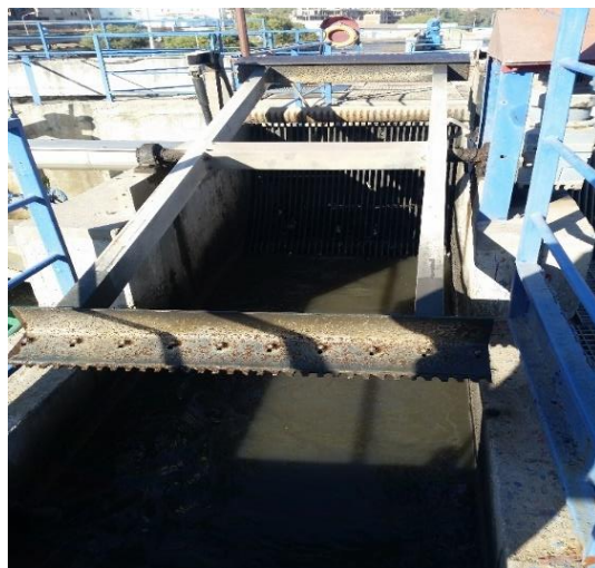
Figure 4-5 Dessaleur automatique de la STEP de Boumerdès
