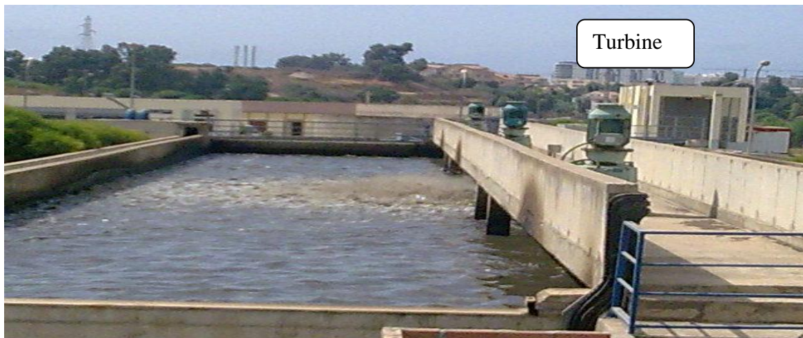
Figure II.7: Bassin d'aération
