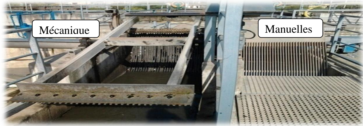
Figure II.5: Dégrillage
