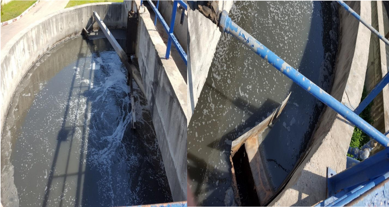
Figure II.6: Le dessablage et déshuilage
