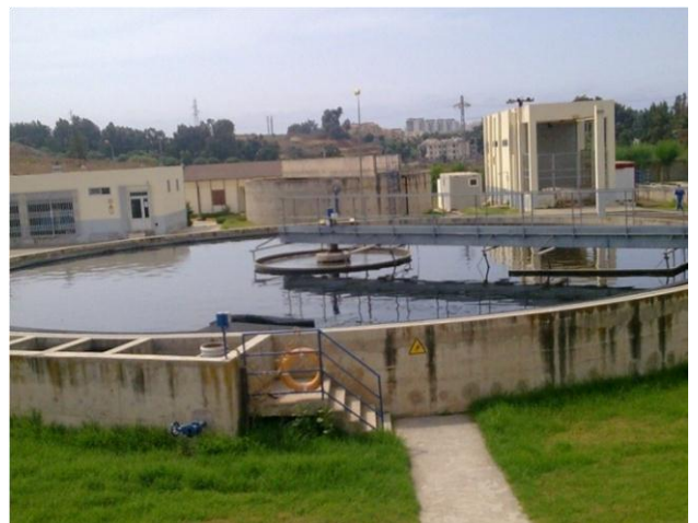
Figure III.6 : Clarificateurs de la STEP de boumerdes
