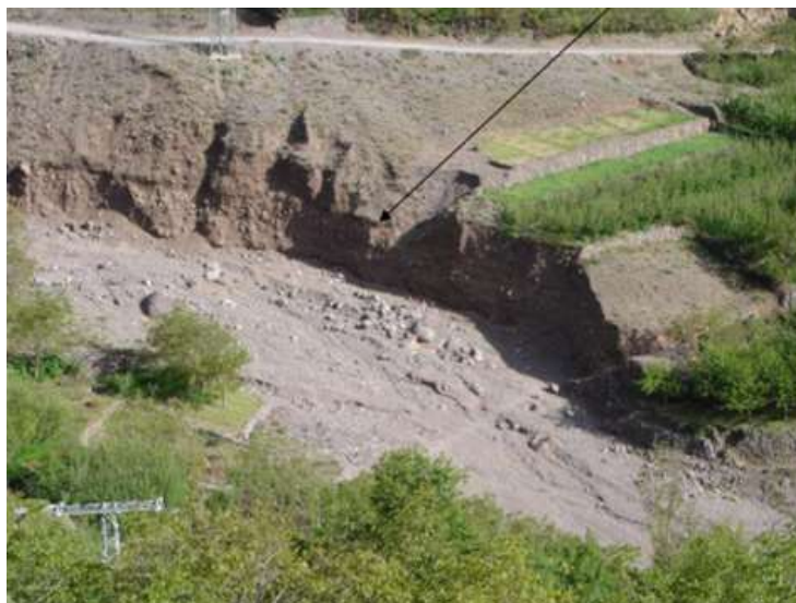
Figure 6 : Erosion hydrographique dans le lit d'une rivière
