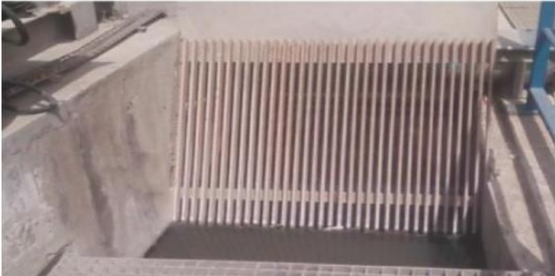
Figure IV. 5 : Dégrilleur du type à champ courbe
