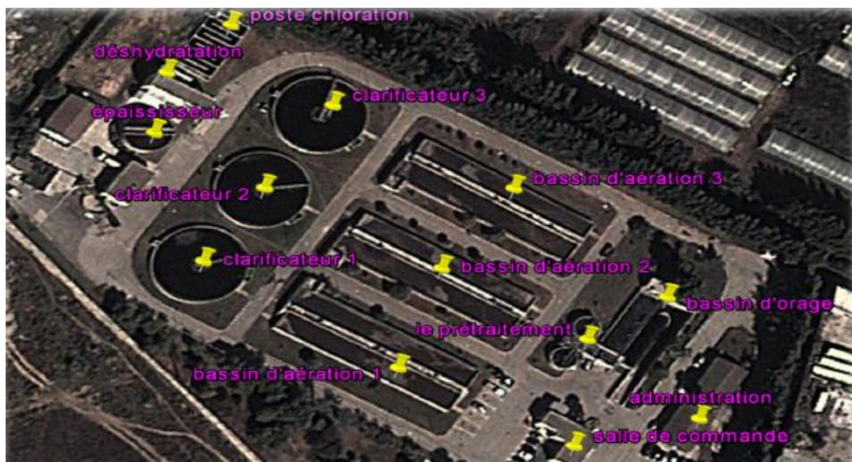
Figure IV. 2 : Vue d'ensemble des ouvrages de la STEP de Boumerdes
