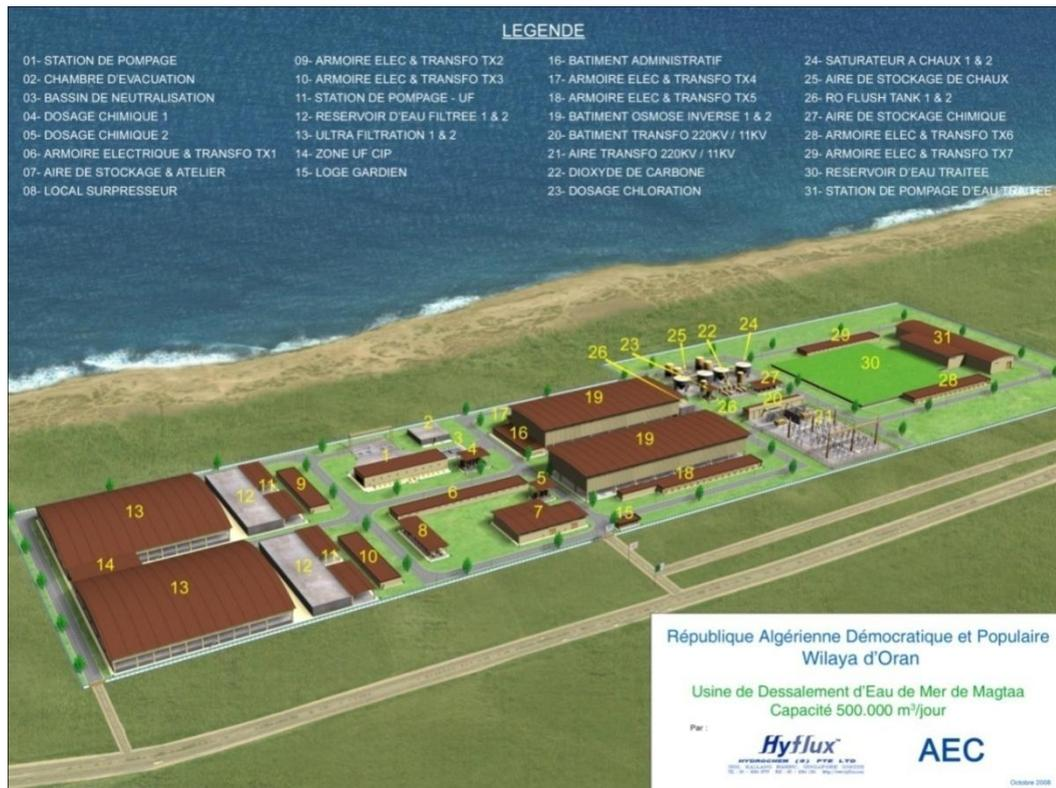
Figure IV. 4: Composition de l'usine de dessalement de Magtâa [21]
