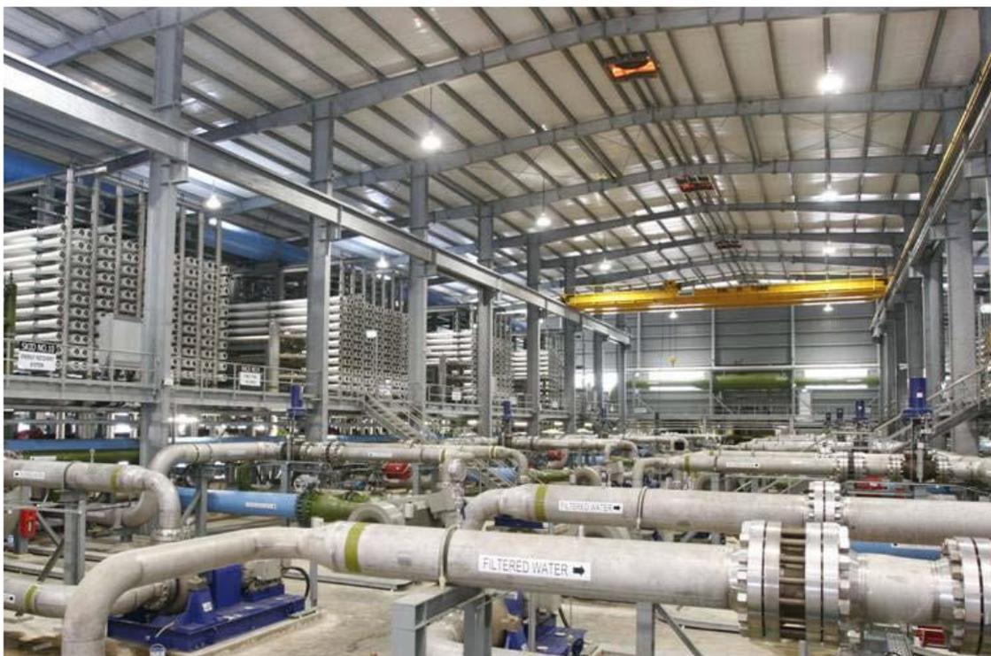
**Figure IV. 8: Système de Membrane d'Osmose Inverse d'Eau de Mer. [21]**
