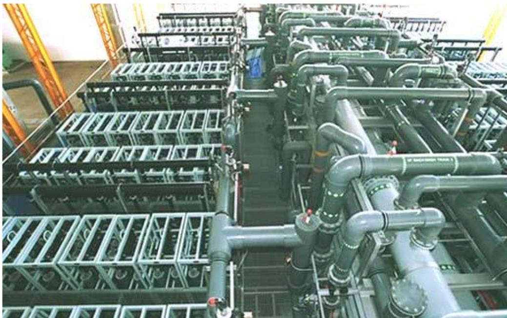
Figure IV. 6: Système de prétraitement – Membranes d'Ultrafiltration
