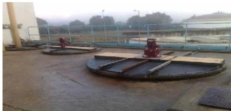
Figure III-12 Bac de conditionnement
