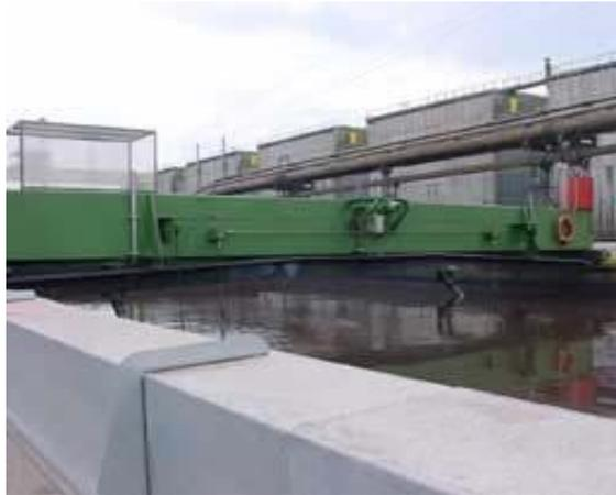
**Figure II-2**Décanteur rectangulaire
