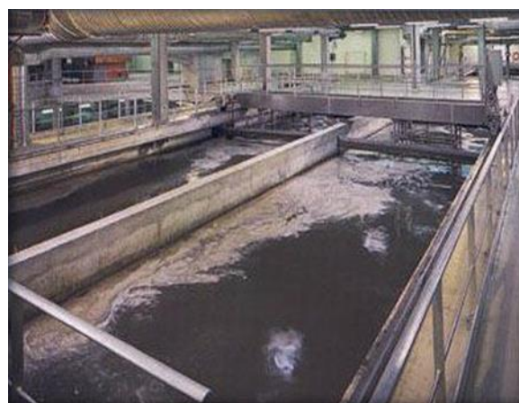
Figure II. 6 Dessableur-Dégraisseur combiné rectangulaire
