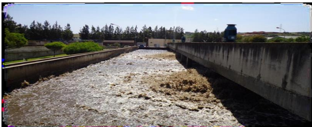
Figure IV. 8 Bassin d'aération
