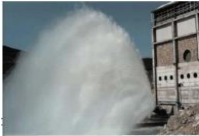
Figure VI. 4: Jet d'eau par une soupape
