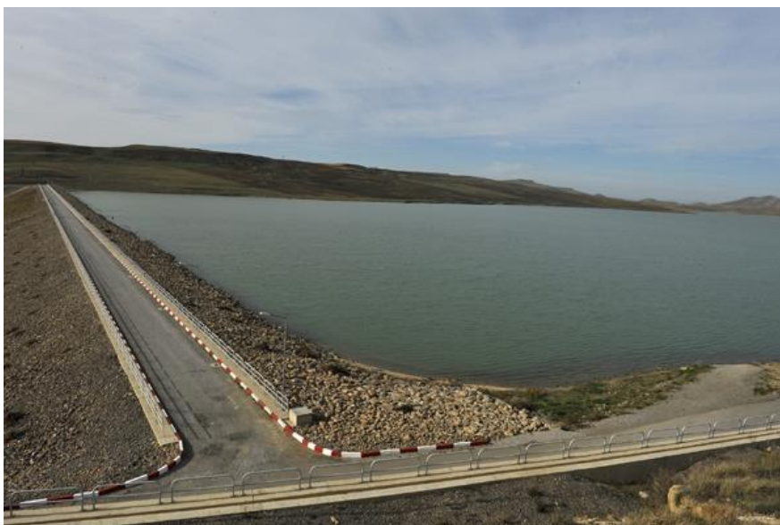
Figure I. 4 : barrage d'Oued Athmania
