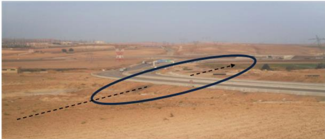
Figure II. 4 : Traversée de l'autoroute
