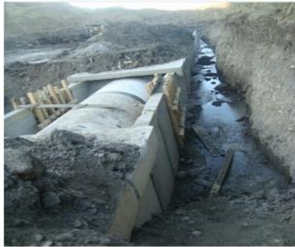
Figure VII. 7: traversé d'un oued
