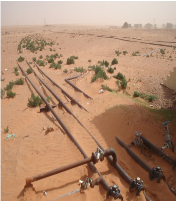
Figure IV. 25 : les conduites de refoulement
