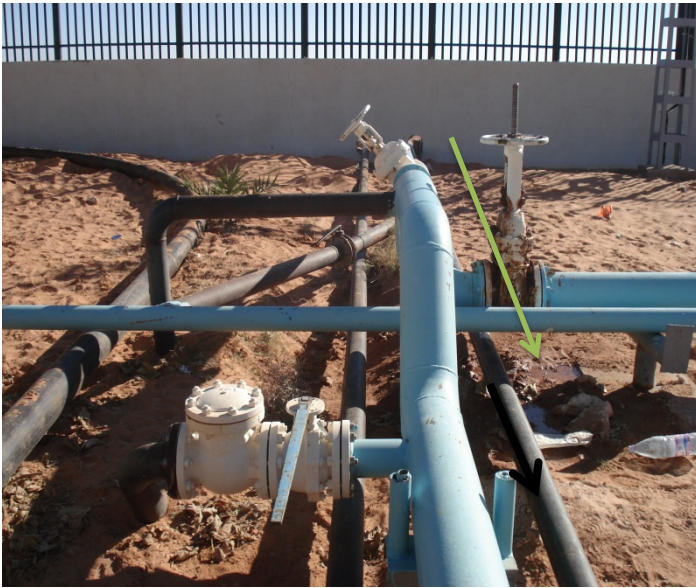
Figure IV. 24 : installation des vannes
