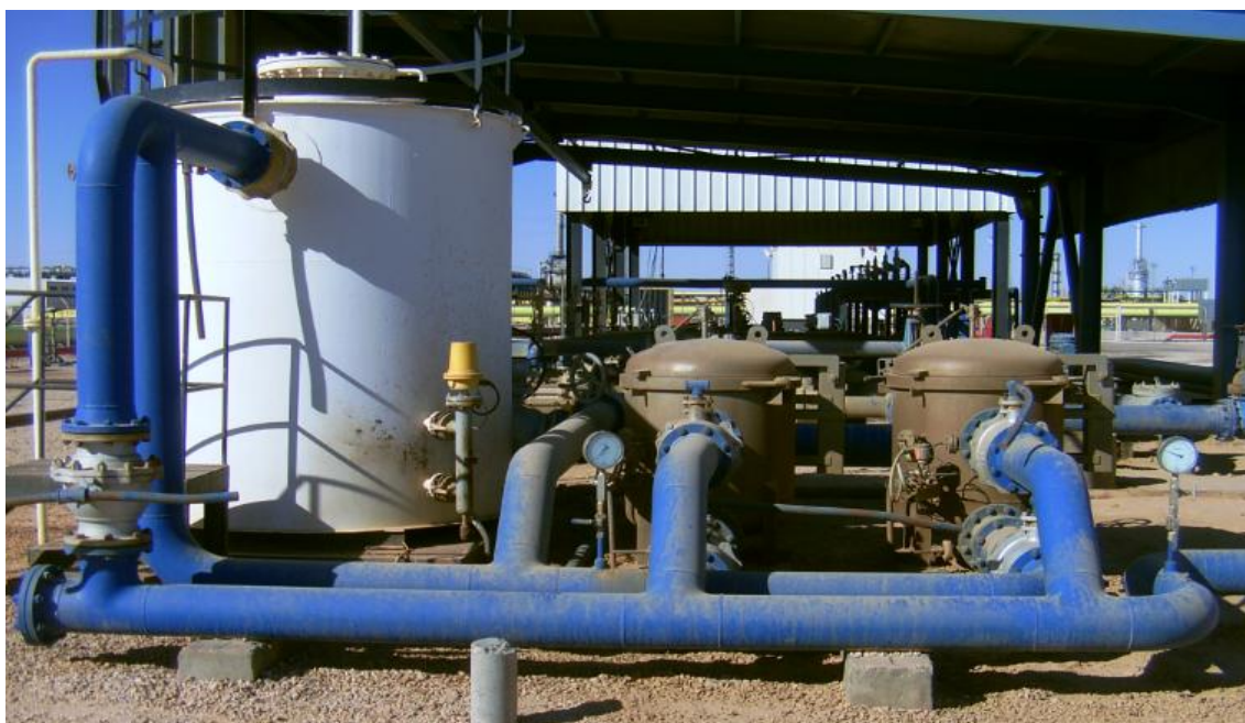
Photo 8 : filtres et réservoir de stockage d'eau traitée de la station de déshuilage du CIS
