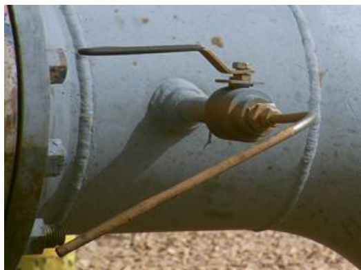
Photo V. 1 : purge de prise d'échantillon
