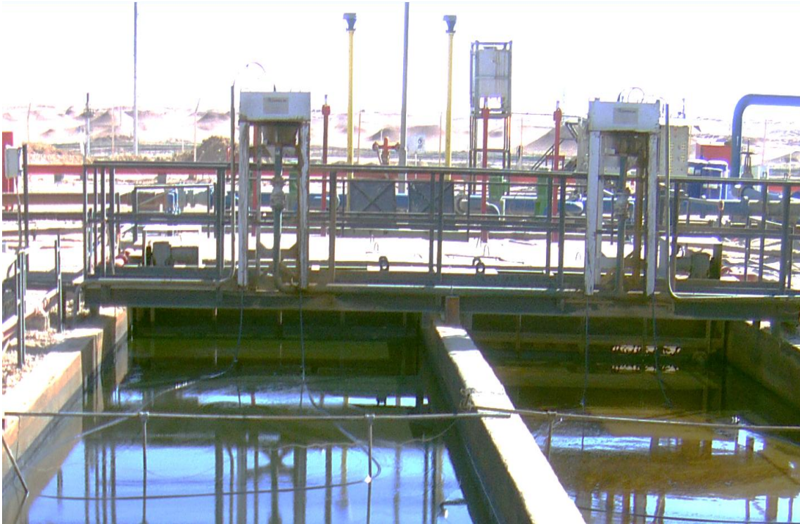
Photo I. 5 : Skimmer à tube oléophile du bassin API de l'unité de déshuilage du CIS
