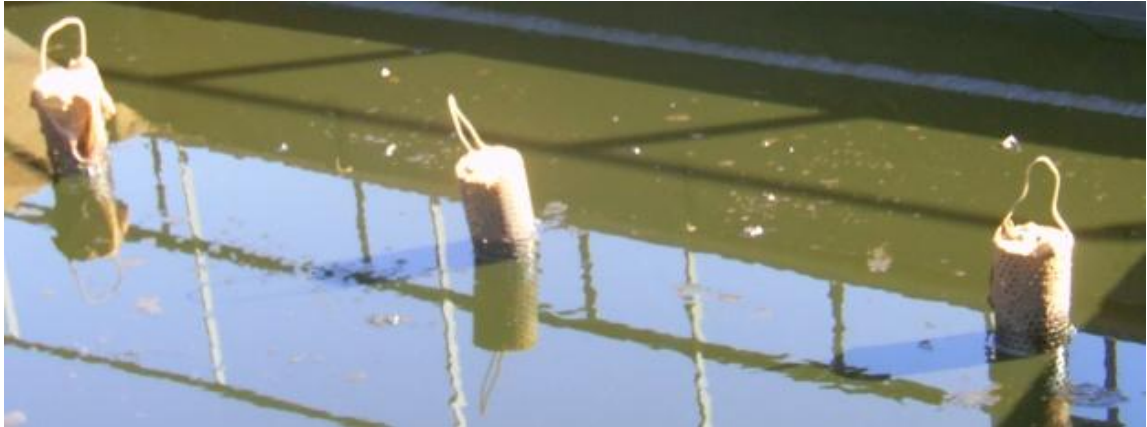
Photo III. 1 : chapeaux chinois bouchés, et la couche d'huile non récupérée
