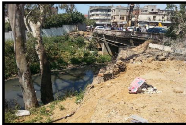
Photo 10 : pont RN5 au centre-ville de Réghaia
