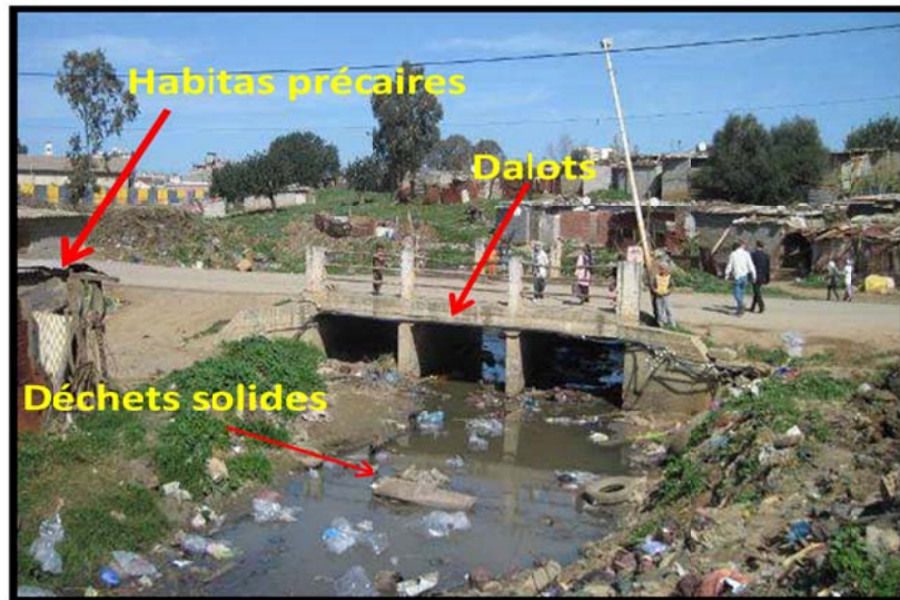
Photo 6: pont du marché
