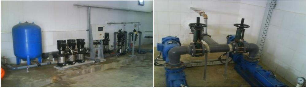
*Figure IV.16 : System de pompage pour l'aspiration des boues en excès*
