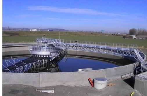
**Figure II.5 :** Décanteur primaire avec pont racler
