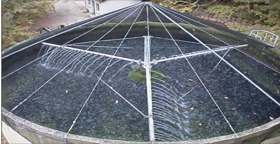
**Figure II.7 :** Lit bactérien avec garnissage traditionnel
