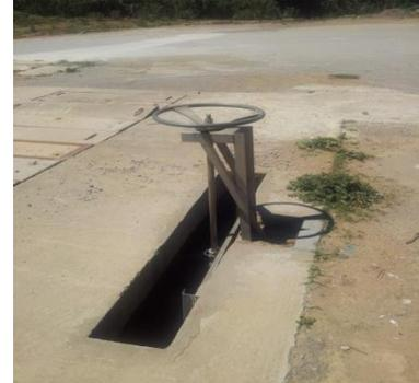
*Figure IV.4 : Déversoir d'orage muni d'une vanne de régulation de débit*
