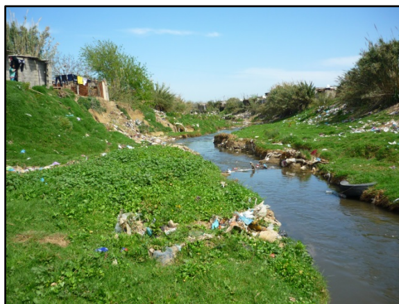
Photo IV.3: déstabilisation des berges par les activités anthropiques et la régression du fond
