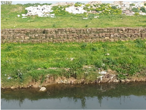
Photo 7 : protection des berges de la rive droite par gabionnage
