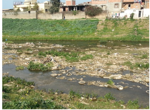
Photo 10 : dépôt de sédiments
