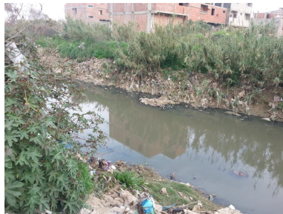
Photo 16 : construction de bâtisse à la limite de la berge
