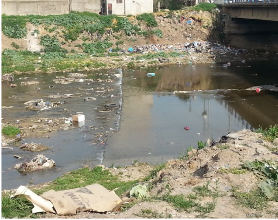
Photo 9 : vue aval du pont d'El Hamiz
