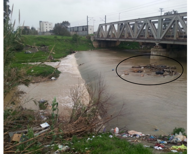
Photo 6 : Pont ferroviaire sur l'oued dont les piles sont sur radier, qui a pour rôle de seuil
