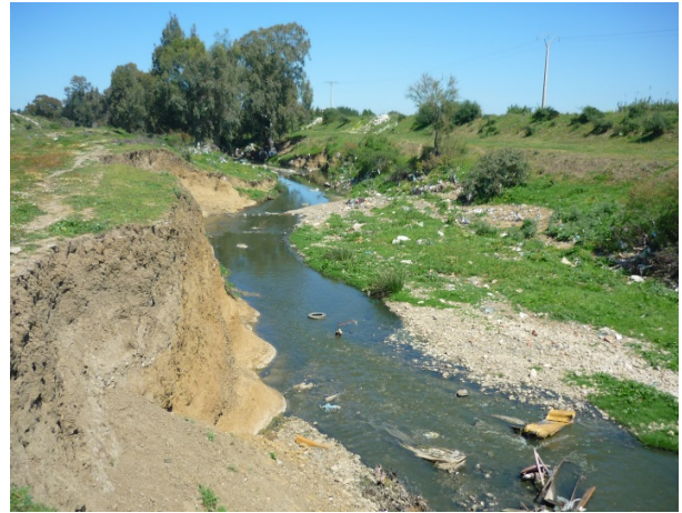
Photo 2 : Eboulement de la berge par sapement des pieds de talus érosion de berges
