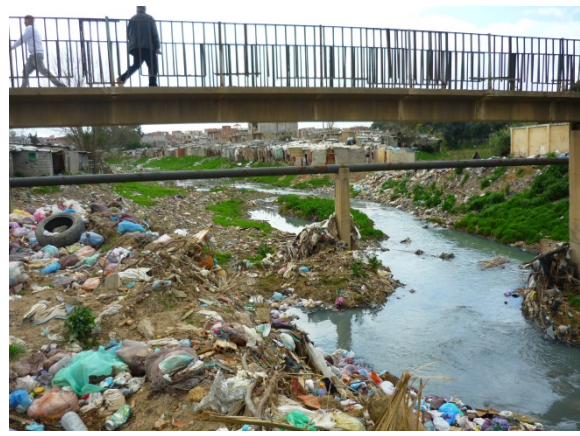
Photo 14 : décharge dans le lit de l'oued
