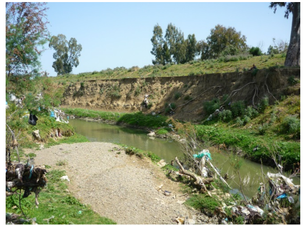
Photo 8 : berges soumises à érosion, l'enracinement des arbres au bon maintien des berges par leurs racines qui fixent le sol.
