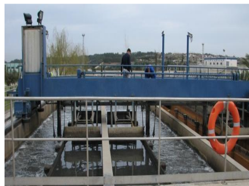
Photo IV.3 : bassin de dessablage-déshuilage
