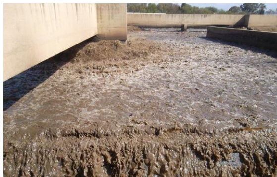
Photo IV.8 : bassin d'aération zone aérée
