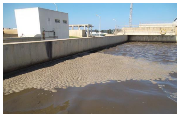
Photo IV.11 : bassin d'aération zone de dégazage
