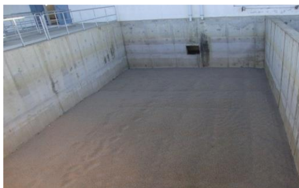
Photo IV.14 : filtration au sable
