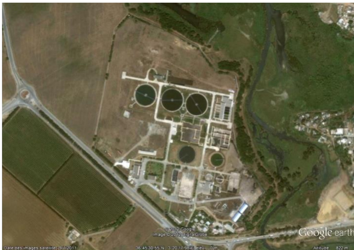
Photo IV.1: vue de dessus de la STEP
