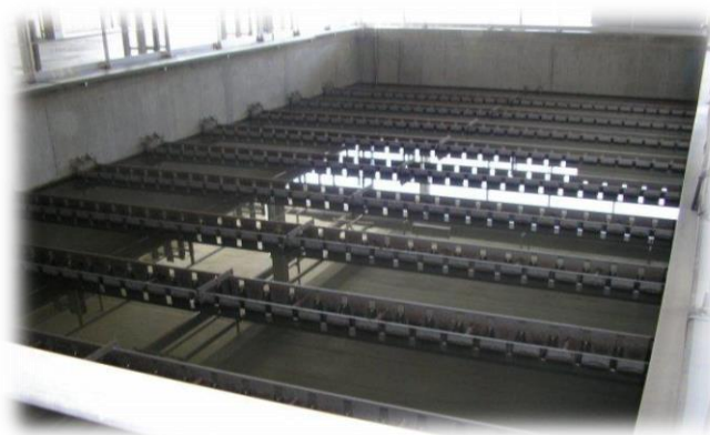
Figure II.5 : Bassin de dessablage
