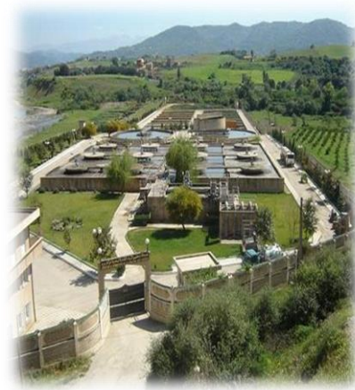
Figure IV.2 : Photo de la STEP de Boumerdes
