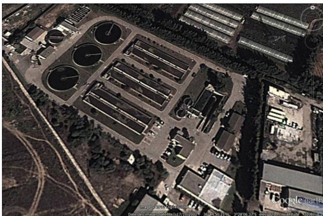
Figure IV.1 : Vue de dessus de la STEP de Boumerdes Par Satellite [Google Earth]
