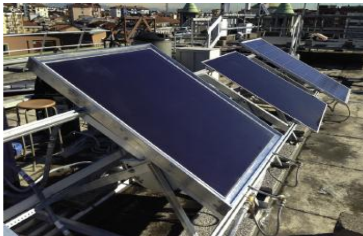
Figure I.24. Capteur PV/T vitré à eau fabriqué au Politecnico di Milano
