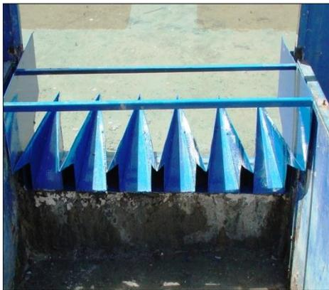
Photo V.09 : PK-Weir de la forme en plan Triangulaire.
