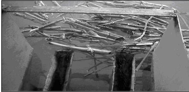
Photo III.02 : Fonctionnement du PKW avec encombrement de l'entrée par des corps flottants.
