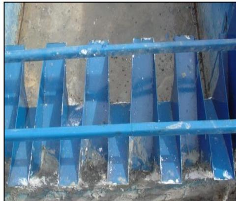
Photo V.10 : PK-Weir de la forme Trapézoïdale.
