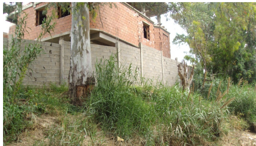
Figure IV-6 : Construction dans le lit moyen
