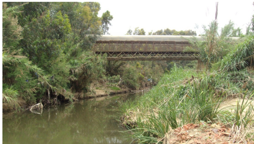
Figure IV-10 : Ouvrage de la briqueterie qui traverse l'Oued
