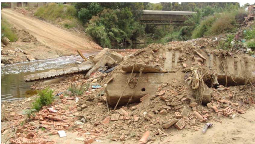
Figure IV-11 : Matériaux solides apportés par la crue de mars 2012
