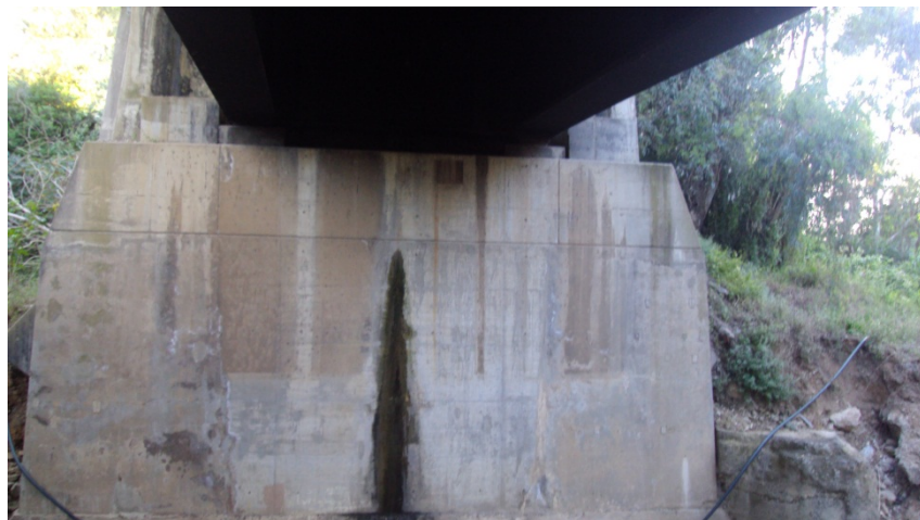
Figure IV-1 : Ouvrage de chemin de fer dans l'Oued
