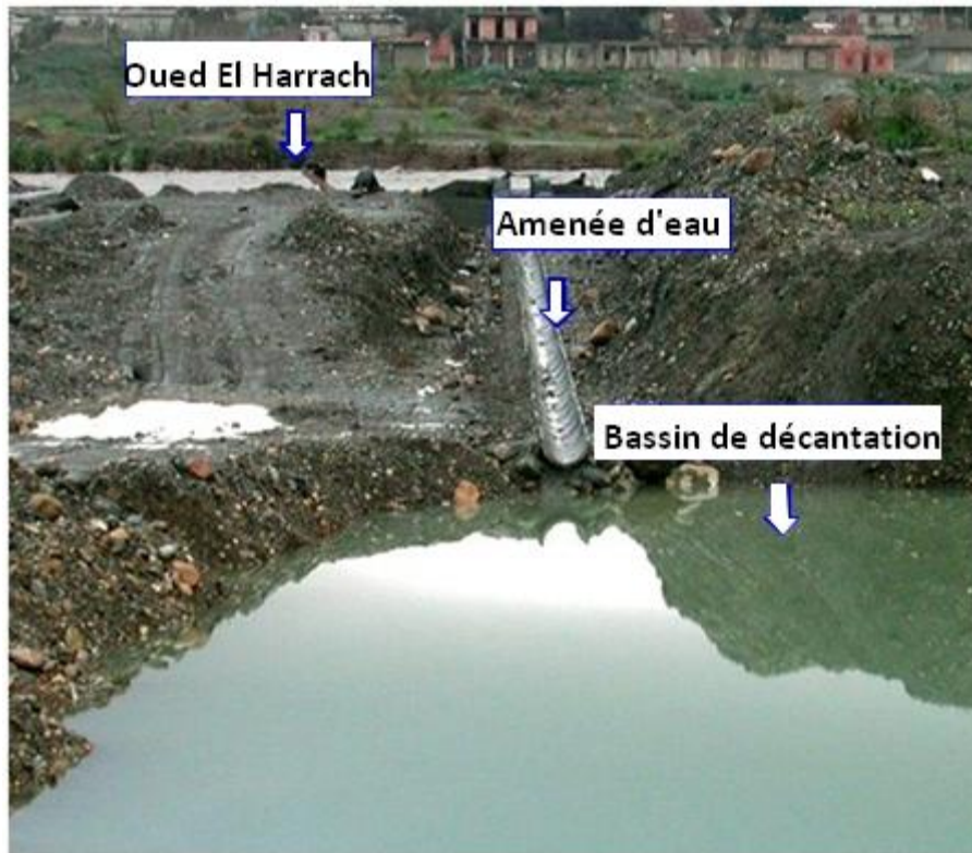
Figure V.4 : Amenée d'eau et bassin de décantation
