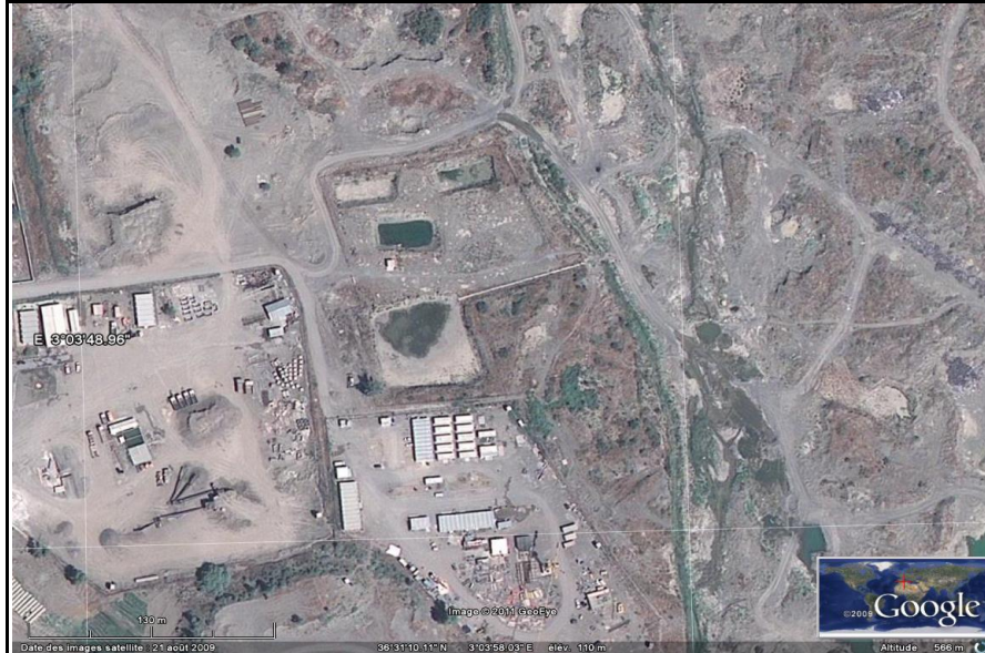
Figure V.2 : Bassins d'infiltration (photo Google Earth)
