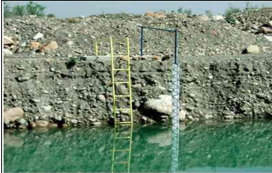
Figure V.6 : Echelle limnimétrique au niveau d'un bassin d'infiltration
