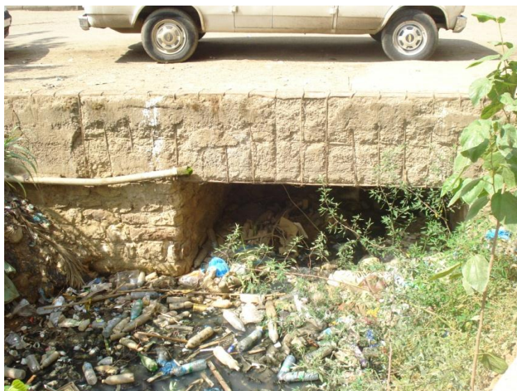
Figure VI.1: Passe sur la RN (Section insignifiante par rapport au débit à évacuer)
