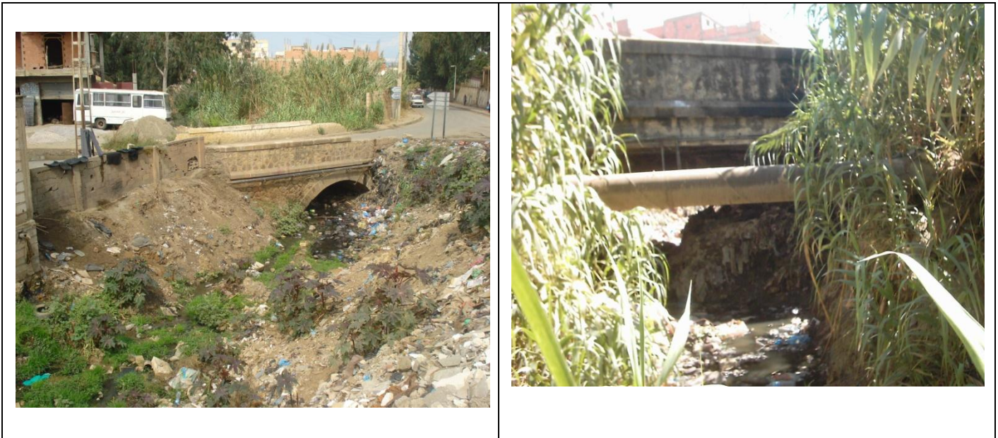
Figure II.7 : Ordure et vase sous passage.
