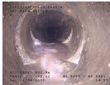
(BAJ.B) Déplacement d'assemblage - Décentrage radial
