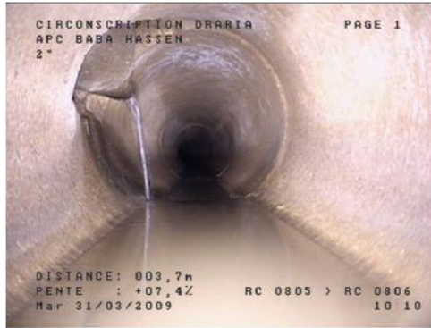
(BCA.E) Raccordement piquage direct buriné à 10h
