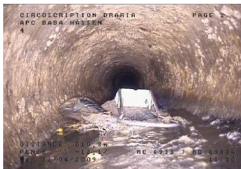
(BBE.C) Obstacles gisant sur le radier
