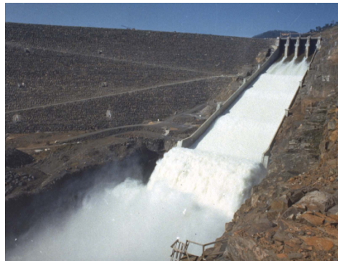
Figure II.6 : coursier du barrage de Foz do Areia (Brésil)
