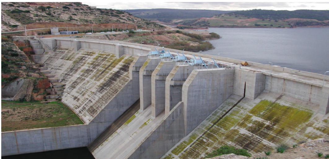
Figure III.2 : barrage de Bouhanifia
