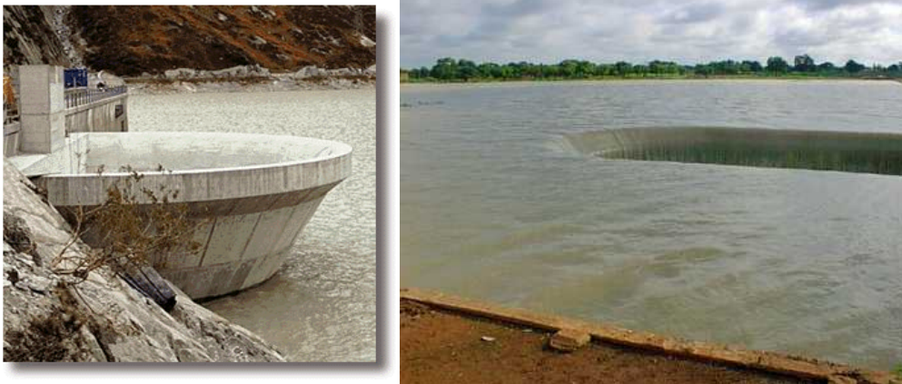
Figure II.2 : évacuateur de crue tulipe
