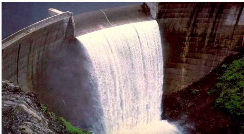
Figure II.3 : évacuateur de surface à seuil libre
