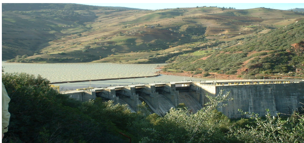
Figure III.4 : barrage de Zardezas
