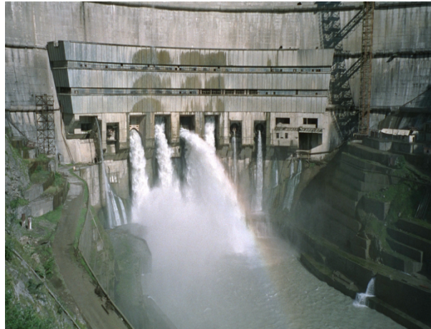
Figure II.5 : évacuateur du fond (pertuis)
