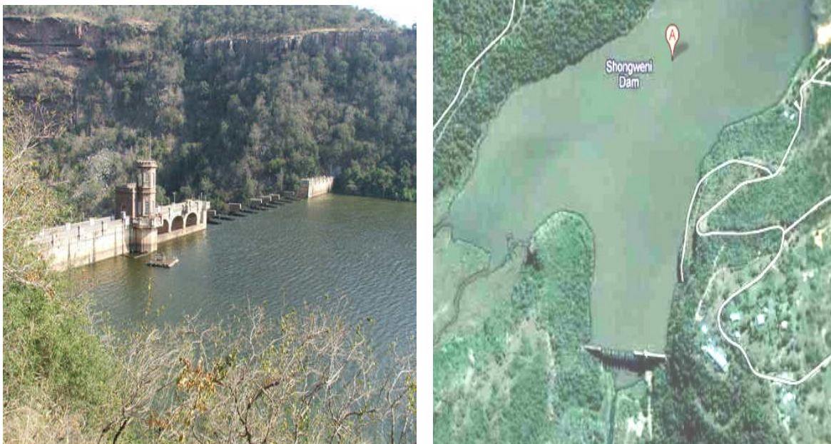
Figure VI.14 : Le barrage de Shongweni équipé par les hausses
