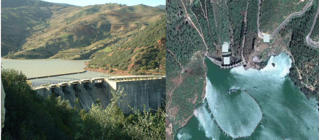
Figure VI.2 : barrage de ZARDEZAS après surélévation
