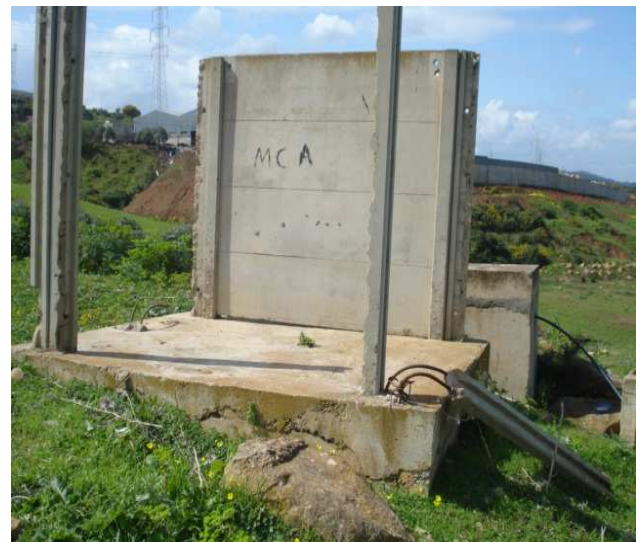
Photo 04 : état de poste.
