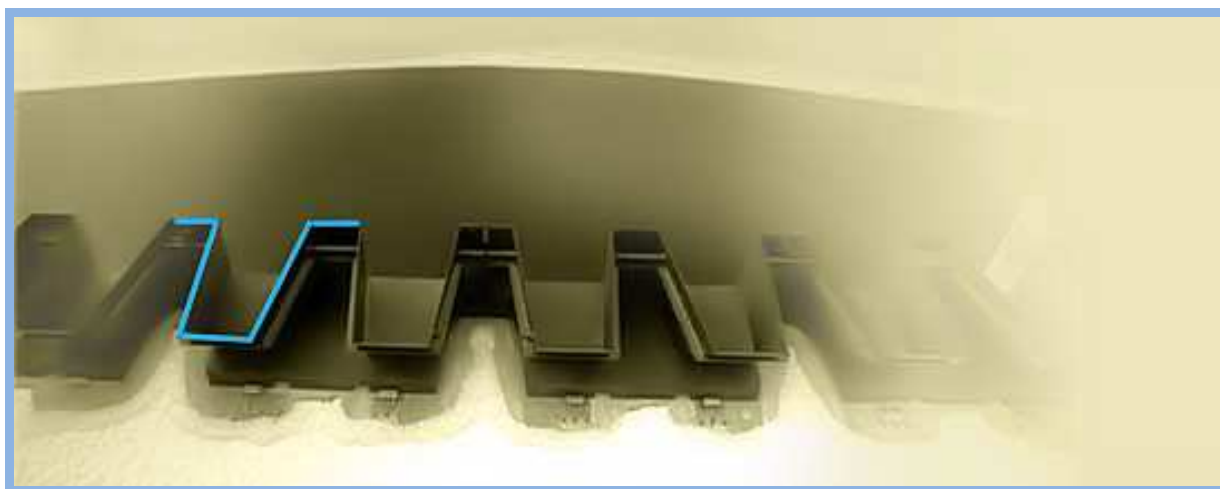
Figure (2.2.2) : vue aval d'une hausse labyrinthe.
