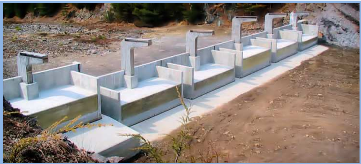
Figure (2.2.14) : hausses posées sur un seuil en marche d'escalier.
