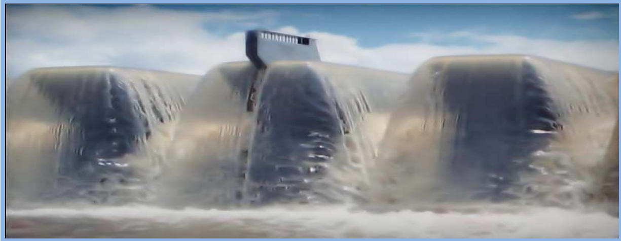
Figure (2.2.13) : deux hausses qui se partage le même puits.
