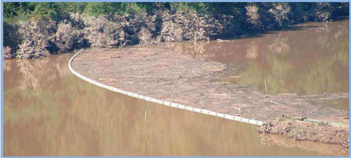
Figure (2.6.2) : capture des corps flottants à l'aide d'une drome.
