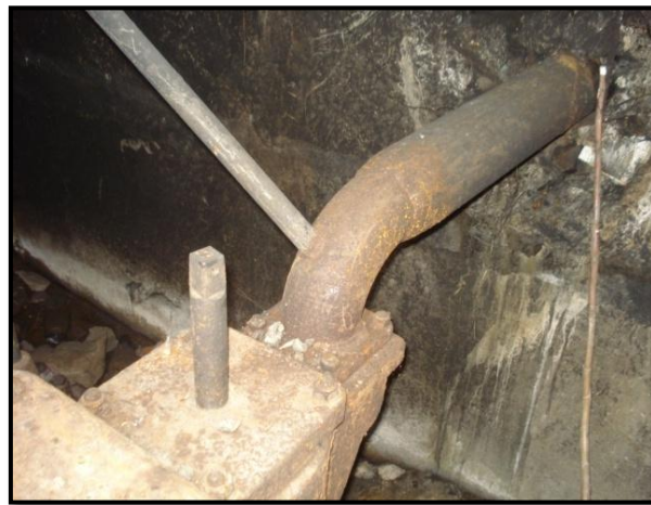
Figure V-7: Piquage illicite d'un diamètre 100 mm situé à Ouled Heddadj
