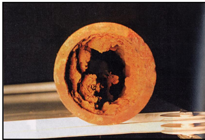
Figure II-7: Conduite ayant subi des dépôts ferriques de corrosion interne.
