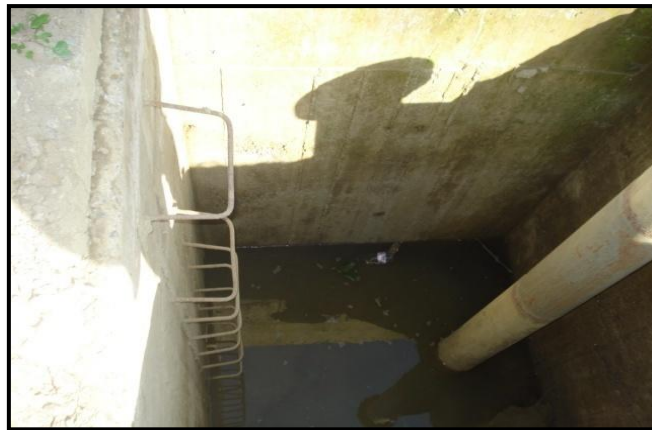
Figure V-4: Chambre de vidange inondée
