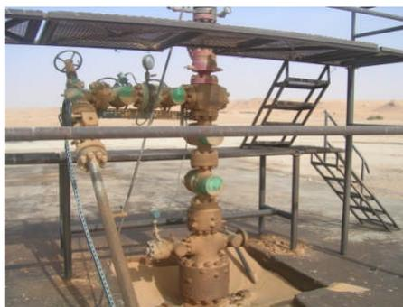
*Figure II-7 : Puits injecteur.*
