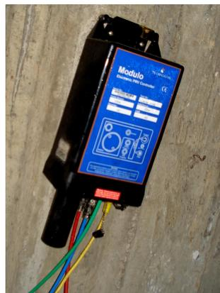
**Figure 3.3 :** *Modulateur de la vanne maitresse de l'étage K 97 - d'Hussein Dey (stabilisateur Moghni).*
