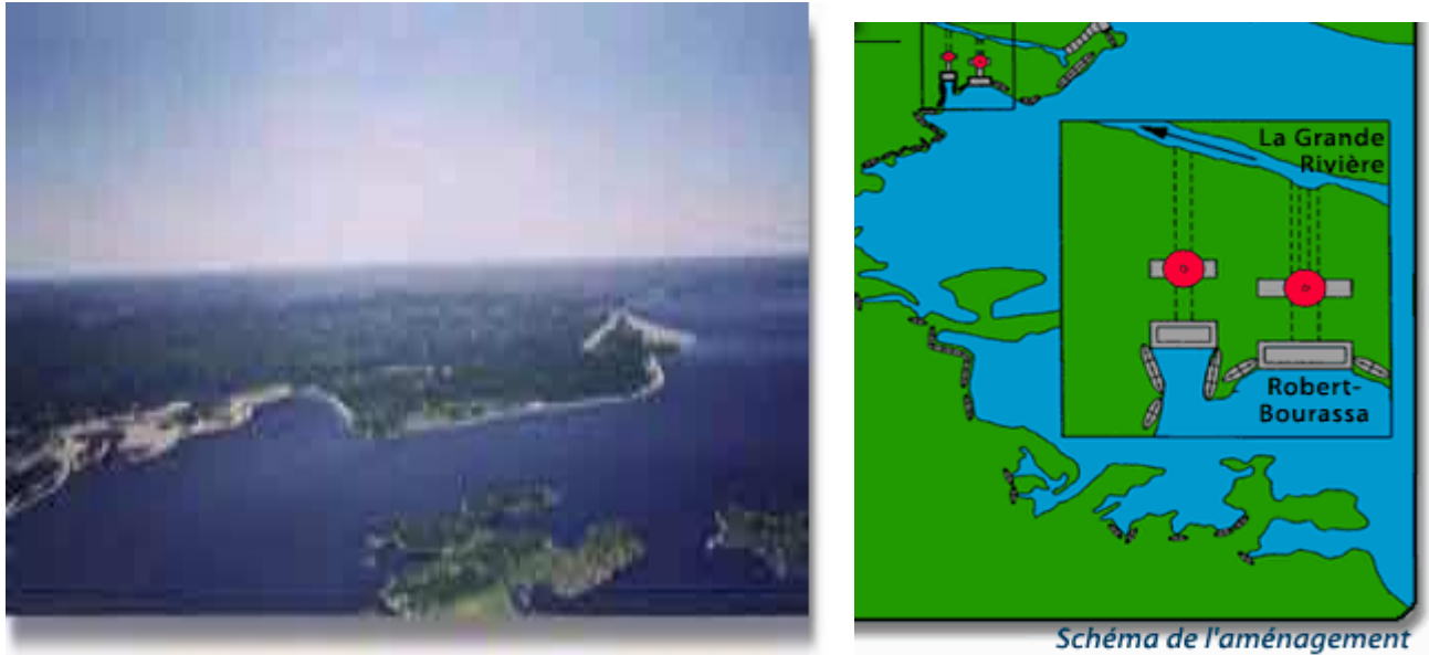
Fig 4.1- centrale Robert-bourassa (canada) type réservoir
