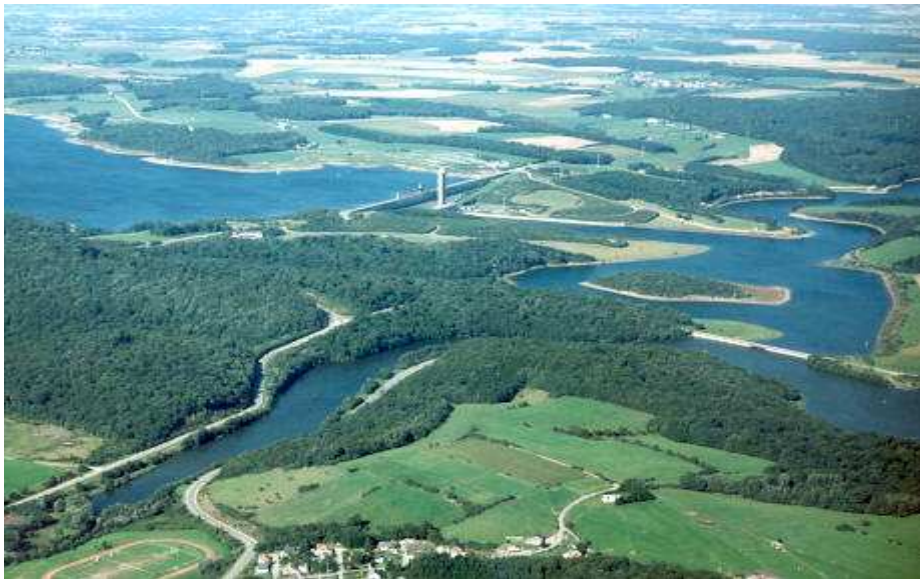
Fig 4.21. Vue aérienne du barrage de la Plate Taille.
