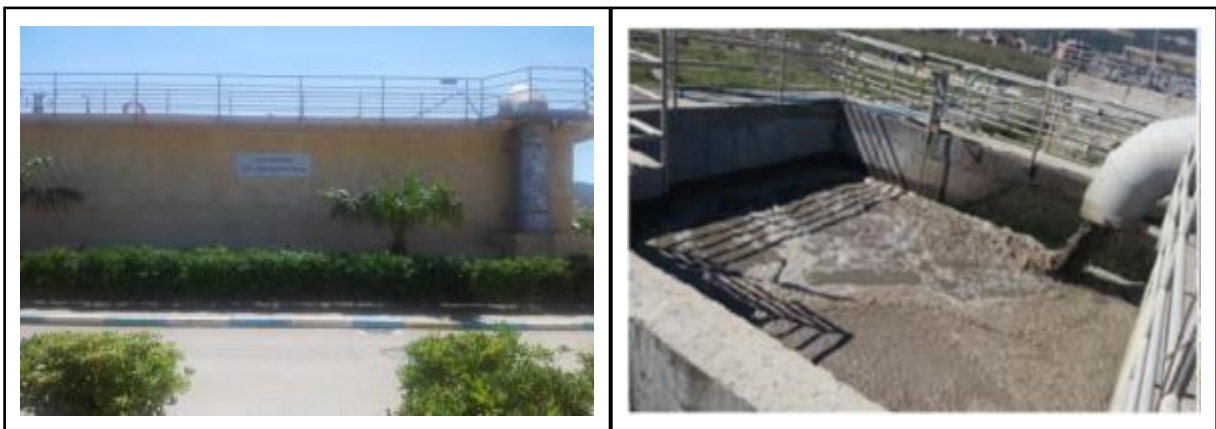
Annexe 15 : Puits de contact (ouvrage de répartition)
