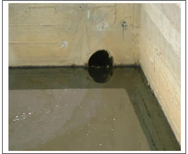
Figure V.19 Canal d'évacuation de lixiviats
