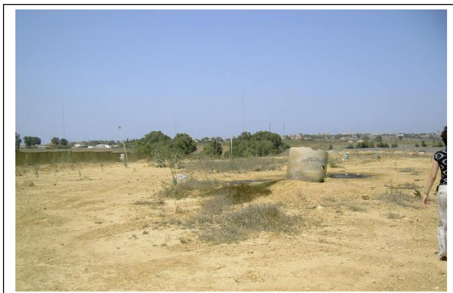
Figure V.15 Système de récupération de BIOGAZ sans traitement, Ouled Fayet AND
