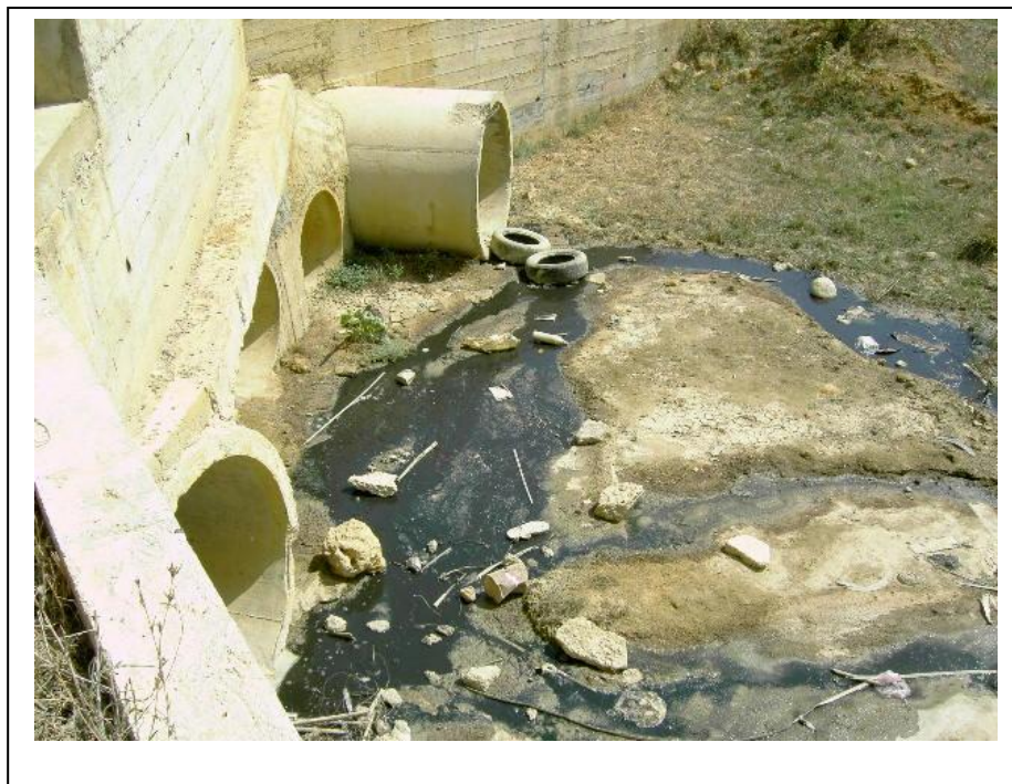
Figure V.20 Canal d'évacuation de lixiviats vers l'Oued Ben Brahem.
