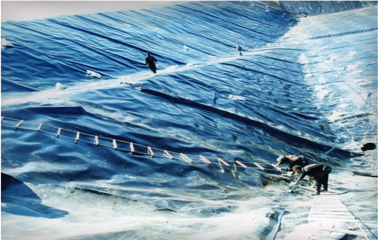
Figure V.10: mise et soudure de la Géomembrane.
