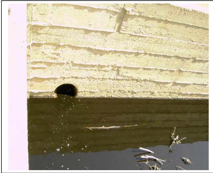
Figure V.18 Canal de réception de lixiviats
