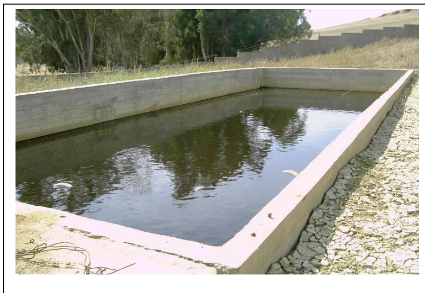
Figure V.17 : Le bassin de décantation de lixiviats.
