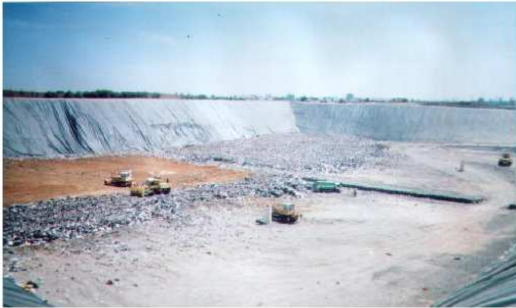
Figure II.4 : L'exploitation du casier N° 5
