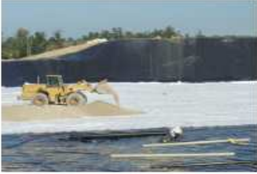
Figure II.7 : Déversement de la couche de gravier.
