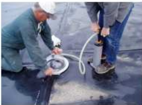
Figure II.5 : mise et soudure de la GMB.
