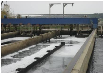
**Photo 4.4** : Bassin de dessablage-dégraissage
