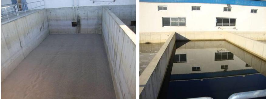
**Photo 4.8 :** Filtre vide et à l'arrêt      Filtre plein pendant le fonctionnement
