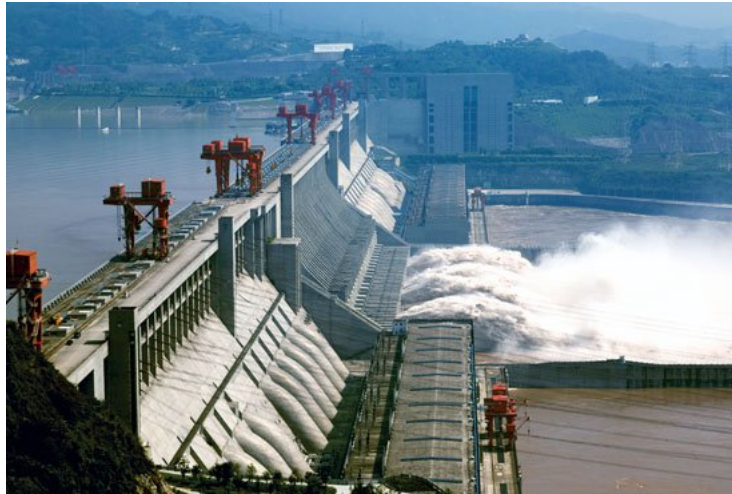
FIGURE 2.1 – Barrage des Trois Gorges sur la rivière Yangtze - Province de Hubei - Chine.
