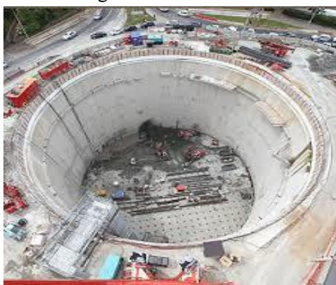
Figure 3.7 : vu d'un bassin de stockage
