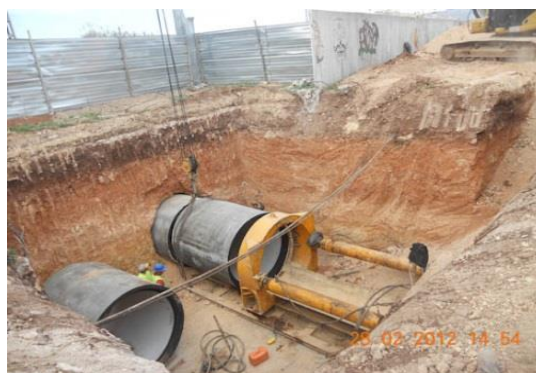
Figure 3.3 : technique de fonçage
