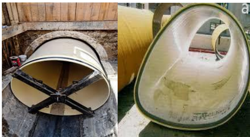
Figure 2.3 : Canalisations en PRV
