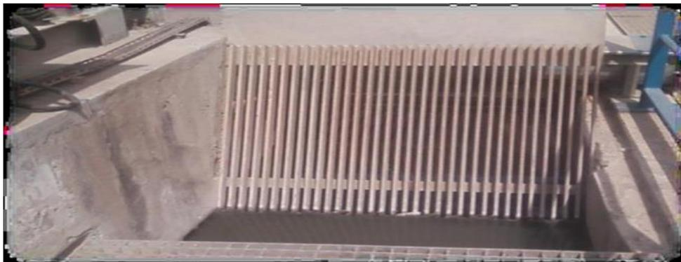
Figure III. 6 Dégrilleur du type à champ courbe.
