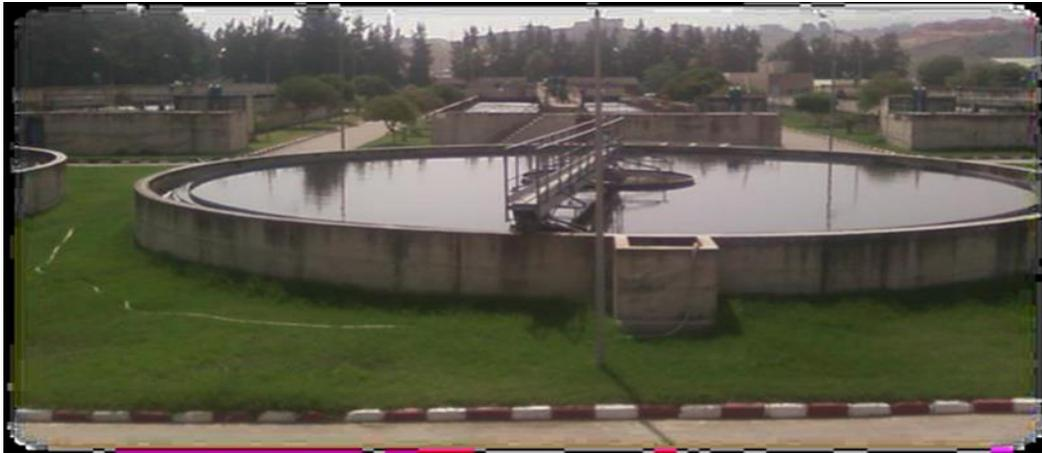
**Figure III. 9 Décanteur-Clarificateur**
