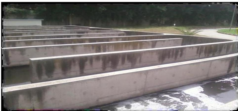
**Figure III. 10 Bassin de chloration**
